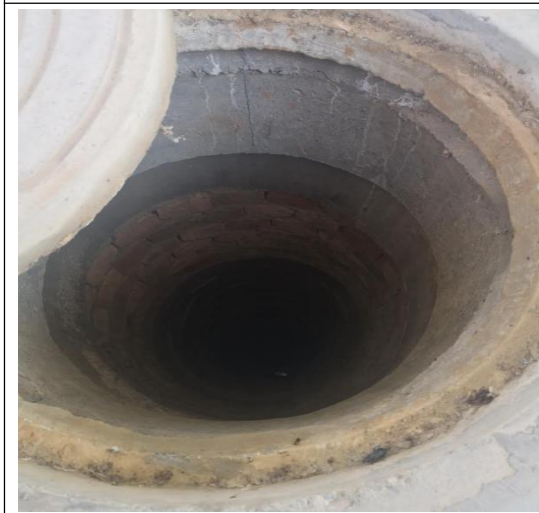
地下水监控井
